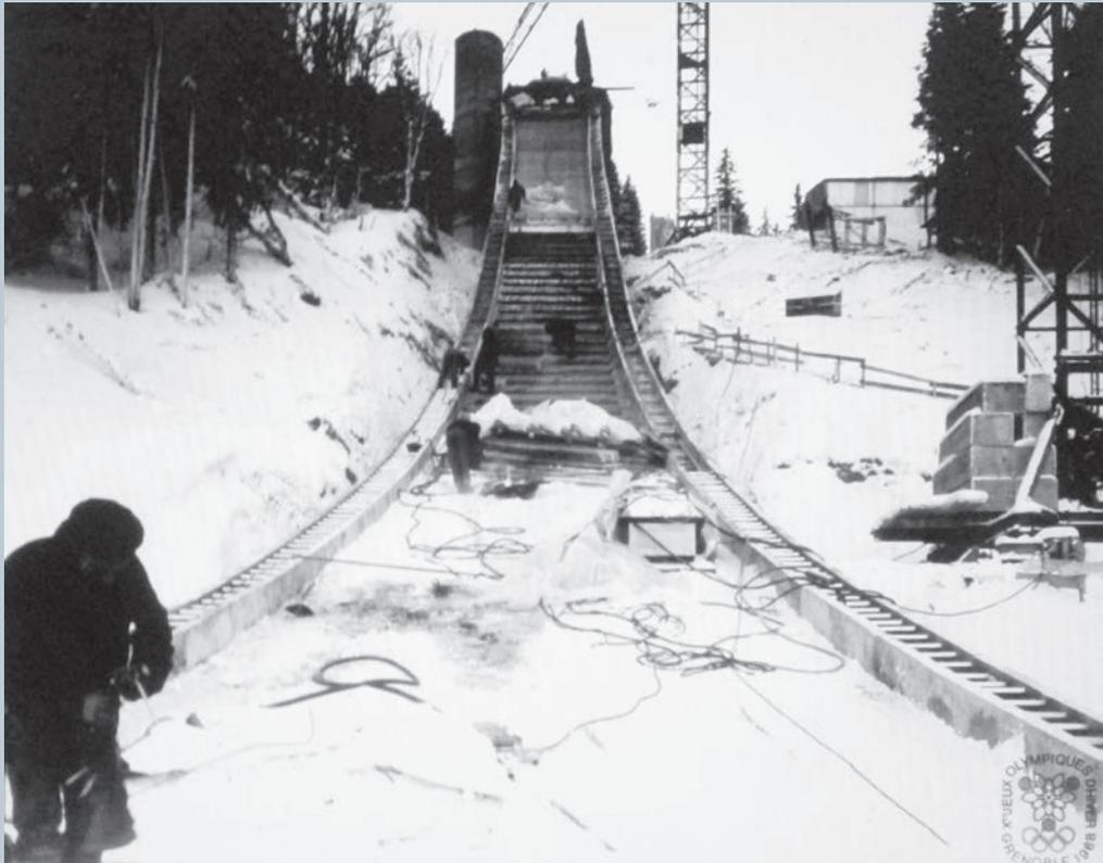
4. Le chantier de construction du tremplin au cours de l'hiver 1966, des conditions qui diminuent les capacités du béton.
